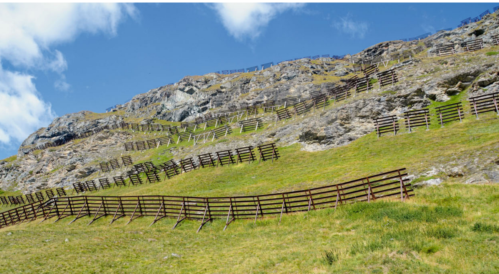
Claies métalliques dans la zone de décrochement d'une avalanche.
