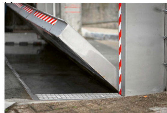
Ein automatischer Klappschott schützt Zugänge vor Hochwasser.
