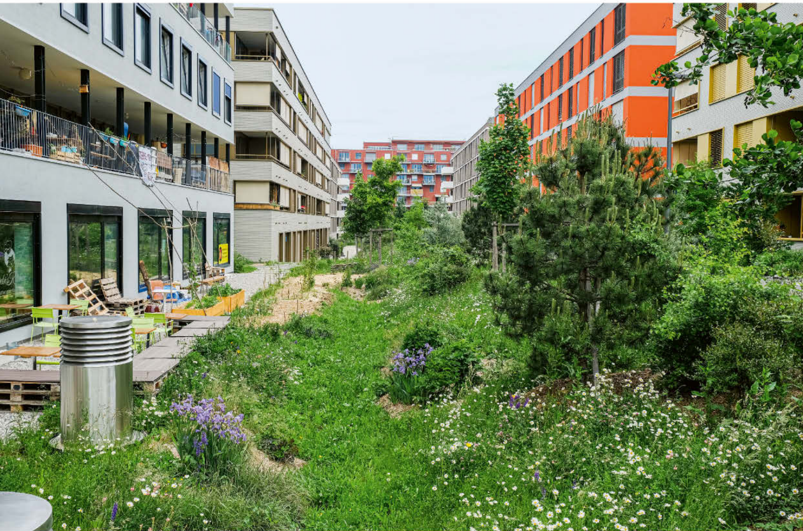
Schwammstadtquartier mit Versickerungsgraben und erhöhten Erdgeschoss und Gebäudeöffnungen.
