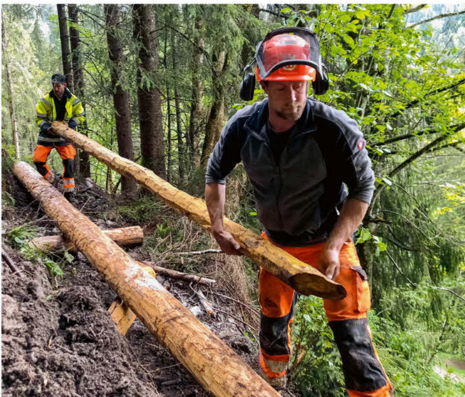
Ein Wegstück im Flühli wird mit Baumstämmen aus dem Wald gesichert. Bild: Denise Lachat
