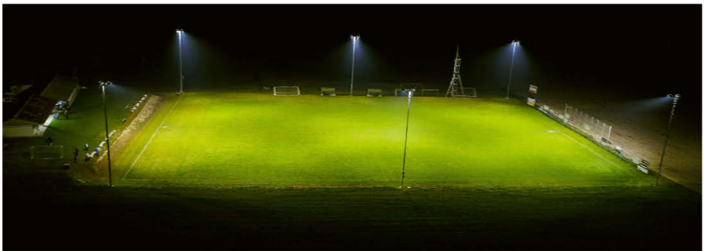
Die LED-Technik auf dem Sportplatz verhindert, dass Licht in unerwünschte Richtungen abgestrahlt wird.
