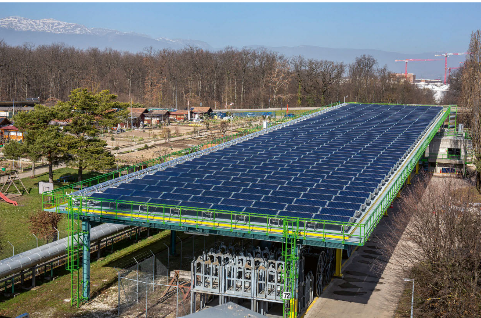
Eine 800 m 2 grosse Solarthermieanlage im Genfer Vorortquartier Le Lignon speist seit Dezember 2020 Warmwasser in das Genfer Fernwärmenetz ein.
