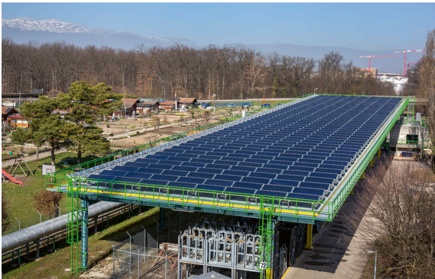
Une installation solaire thermique de 800 m 2 dans le quartier du Lignon, en banlieue genevoise, alimente en eau chaude le réseau de chauffage urbain de Genève depuis décembre 2020.
