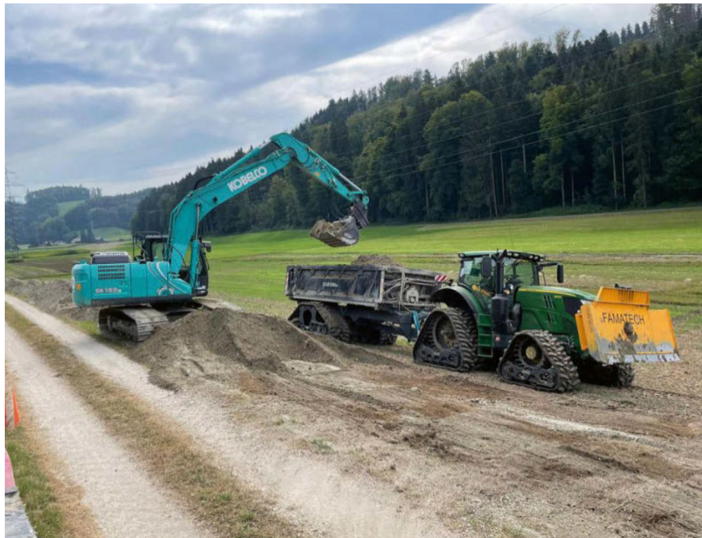
Traktor und Anhänger fahren mit Raupen statt Rädern, damit der Druck auf den Boden nicht zu gross ist und dieser nicht zu stark belastet wird.
