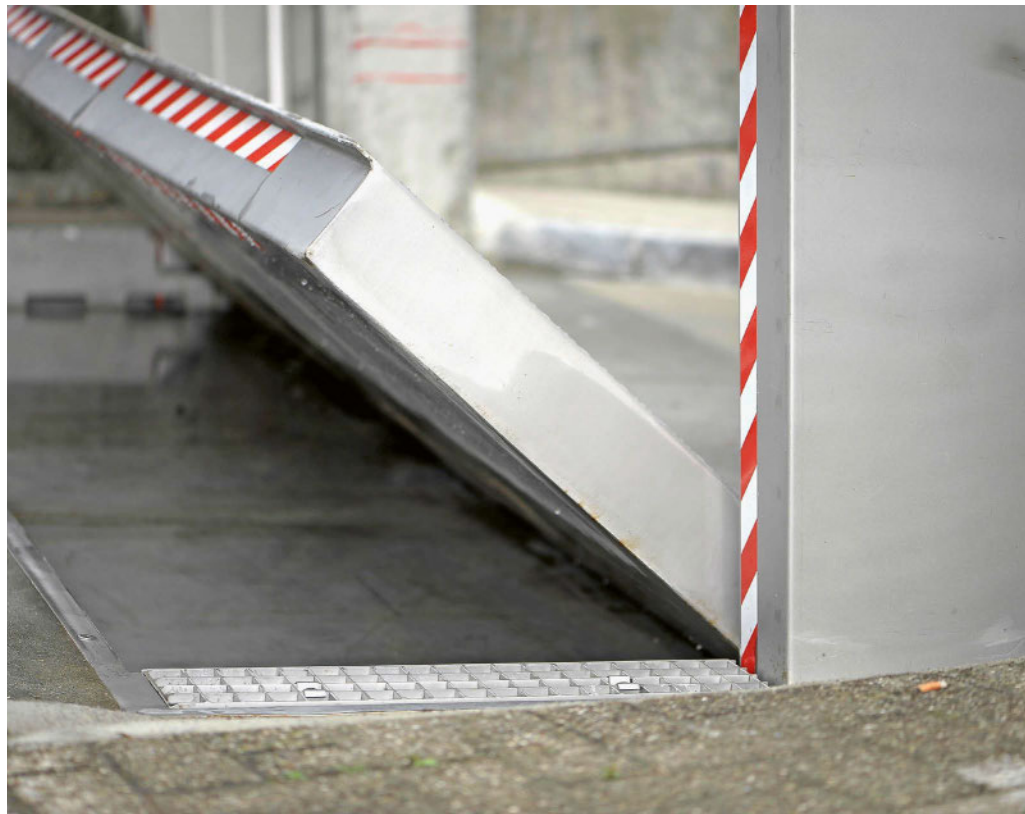
Ein Klappschott schliesst sich ab einer gewissen Wassermenge von selbst und verhindert so die Überflutung von Tiefgaragen.
