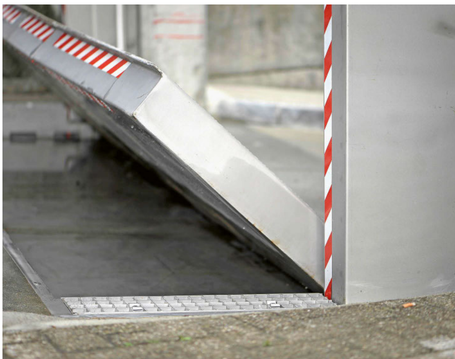
Dans le cadre de la protection contre les crues, il est possible d'installer des barrières rabattables automatiques entièrement mécaniques à l'entrée de parkings souterrains.
