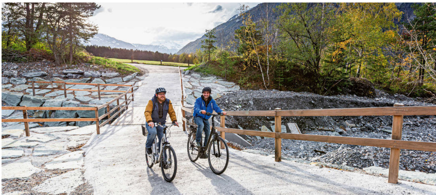
Die neue Querung der «Maschänserrüfe» sichert den Betrieb des Radwegs bei Regen und gewährleistet bei Extremereignissen ein Überspülen und den Gieschiettransport.
