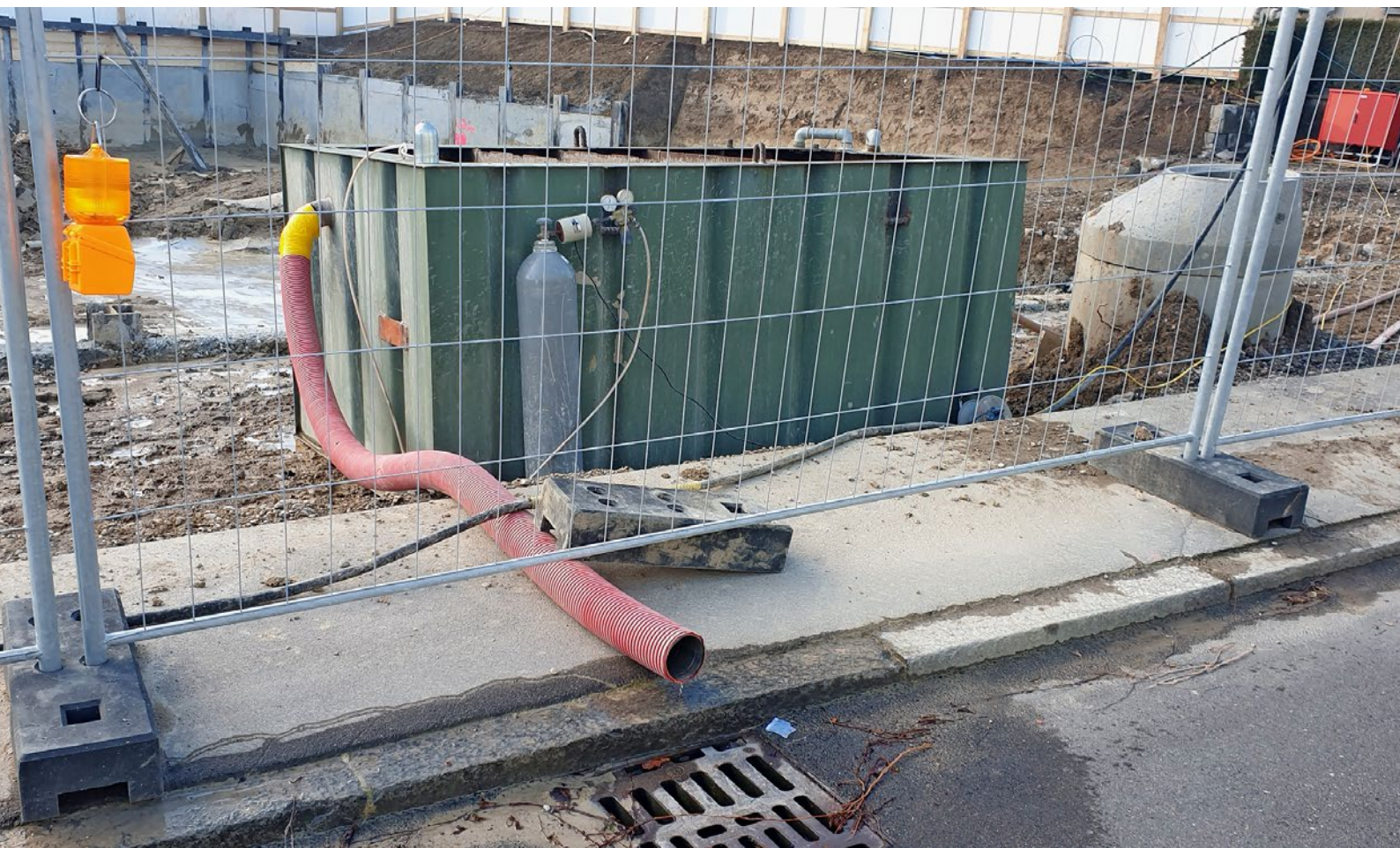
Behandeltes Baustellenabwasser wird über den öffentlichen Strassensammler in die öffentliche Kanalisation abgeleitet.
