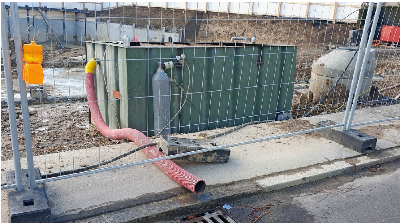
Les eaux usées de chantier traitées sont évacuées dans les égouts publics par le collecteur public de la route.
