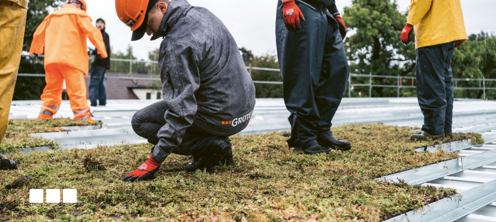
Dachbegrünung mit ECOSEDUM® durch die Grüter-Handels AG
